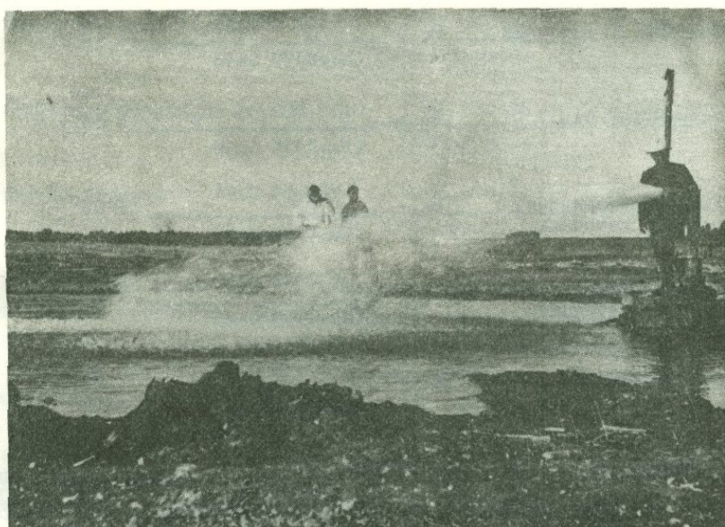
Рис. 22. Личское месторождение минеральных вод. Фонтанирующая скважина
