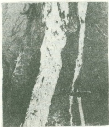
Фиг. 18. Нарушение 2-е западное. Фото стенки выработки.
