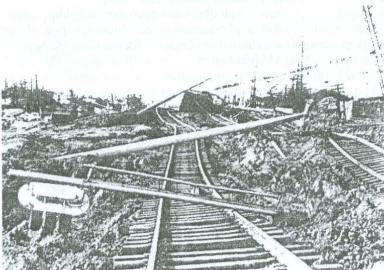
Նկ. 3.32 Նալբանդ կայանի երկաթուղային ճանապարհի տեղամասի վնասվածքները [152]:
