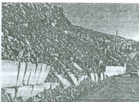
Նկ. 3.30 Երկաթբետոնե հենապատերի փլուզումներ Սպիտակի մերձակայքում [89]:
