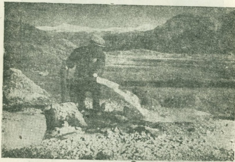
Фиг. 14. Скважина № 9 по окончании работ.
