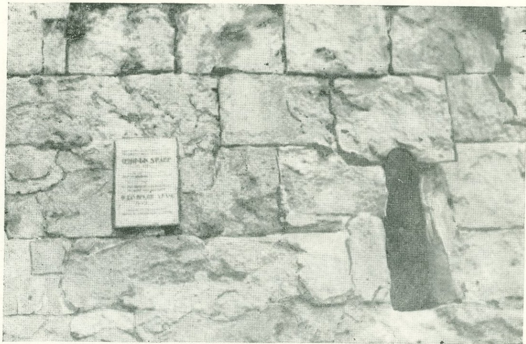
Фиг. 3. Одзунский храм, VI—VII вв. Облицовка южного фасада на высоте 2—3 м.
