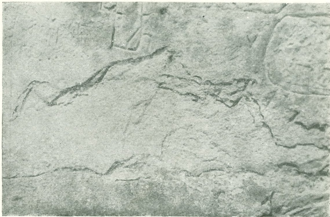
Фиг. 34. С. Калача Ноемберянского района. Старая церковь. Выветривание калачинского фельзитового туфа в облицовке стен.
