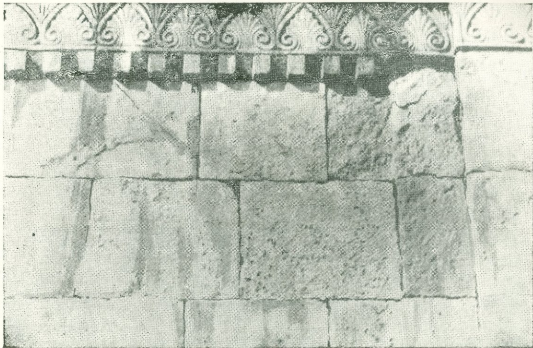
Фиг. 49. Летний ресторан «Москва», 1945—1946 гг. Облицовка стены из туманянского туфа (карниз бетонный).
