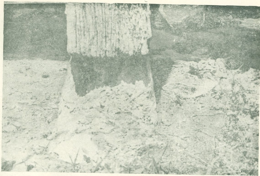
Фиг. 38. С. Калача Ноемберянского района. Выветривание каменной базы деревянного столба в жилом доме С. Эзданяна,
