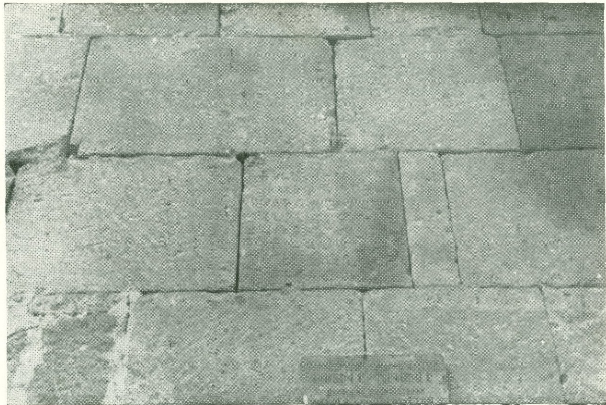
Фиг. 101. Церковь в Бюракане, 898—931 гг. Облицовка на высоте 5—6 м от уровня земли.
