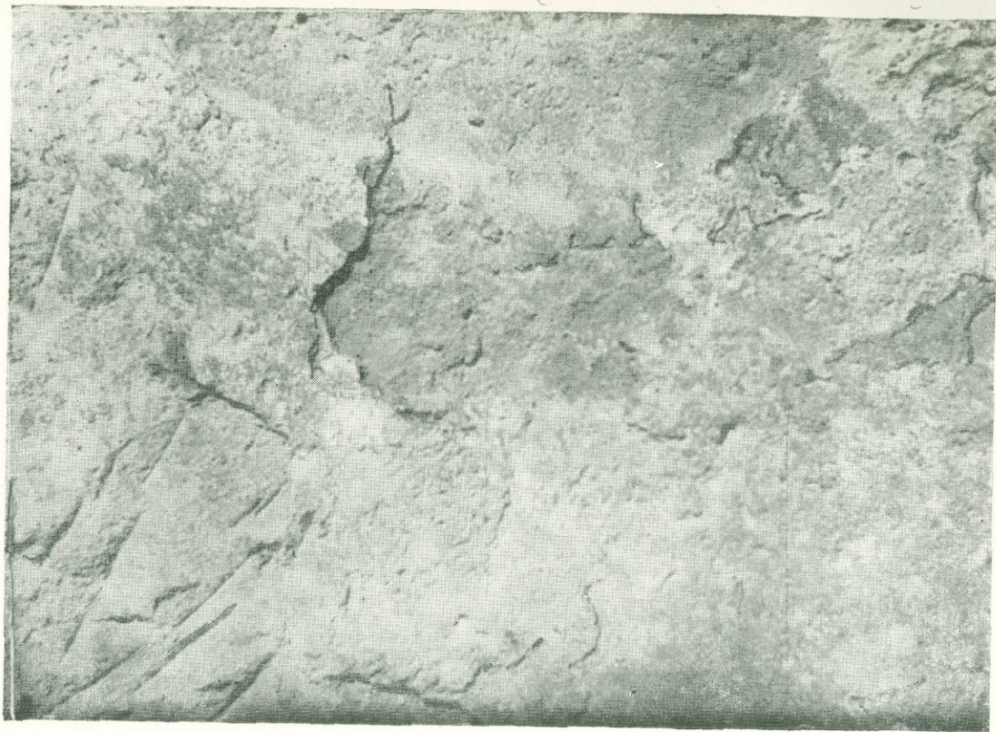
Фиг. 79. Церковь в с. Маисян, VII в. Камень нижнего ряда с внутренней стороны стен. Коркообразование.
