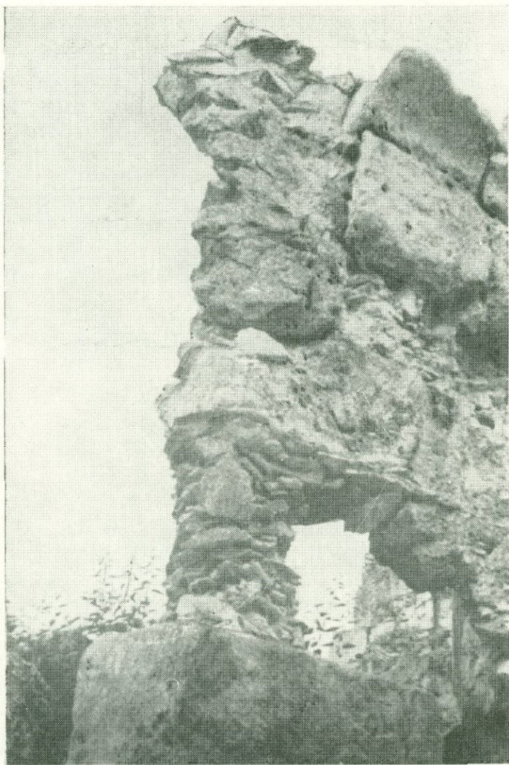
Фиг. 15. Хневанк, X в. Левое крыло с юга. Бутовое заполнение стены, стоящее без облицовки.
