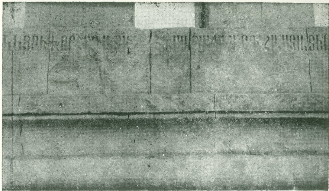
Фиг. 47. Надпись на памятнике в Узунларе, частично стертая в результате выветривания туфа.
