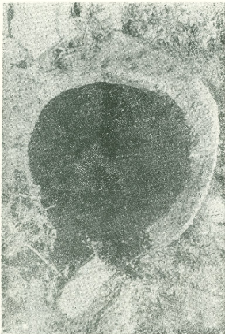
Фиг. 26 Мельничная труба в Ноемберяне, выдолбленная из фельзитового туфа.
