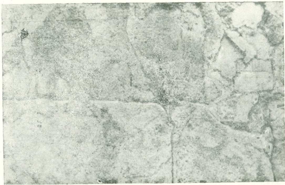
Фиг. 39. Старая церковь с. Шахназар. Облицовка северо-западного фасада, на высоте 1 м от земли.
