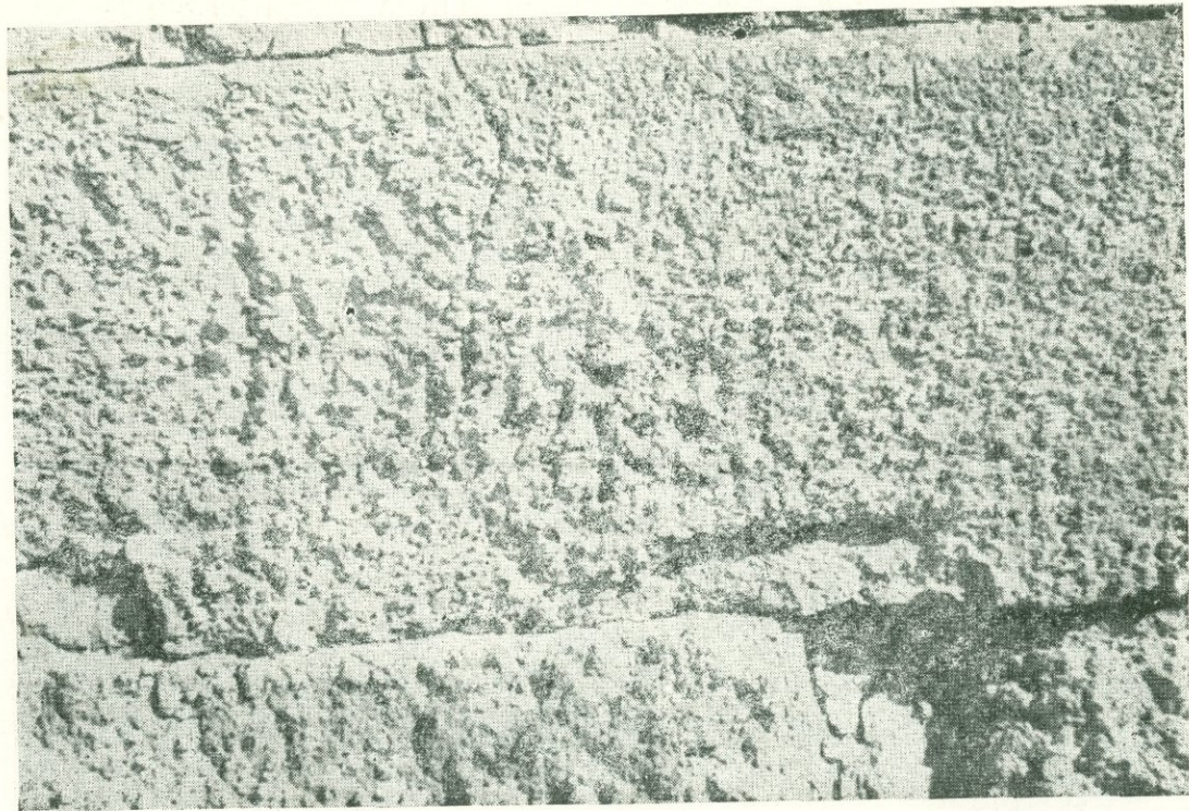
Фиг. 109. Ереуик, V—VI вв. Выветрелый камень на западном фасаде (нижние ряды).
