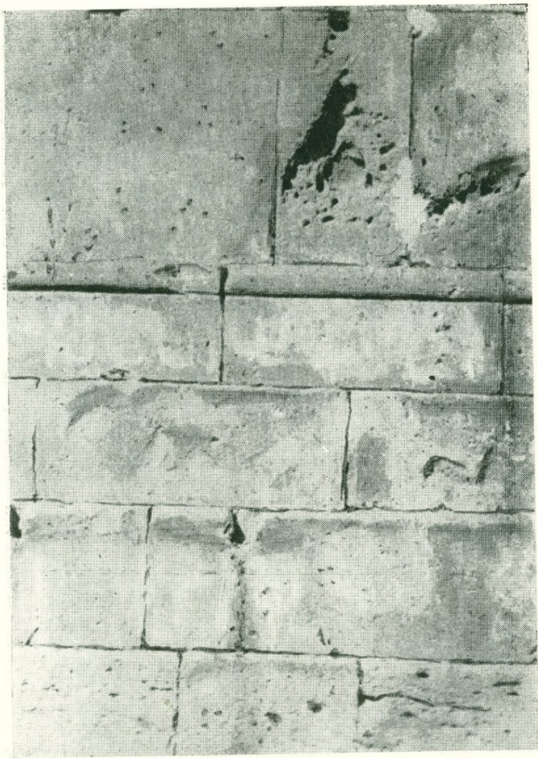
Фиг. 121. Аричский монастырь, 1201 г. Фрагмент ступенчатого покая и первого ряда облицовки стен восточного фасада.
