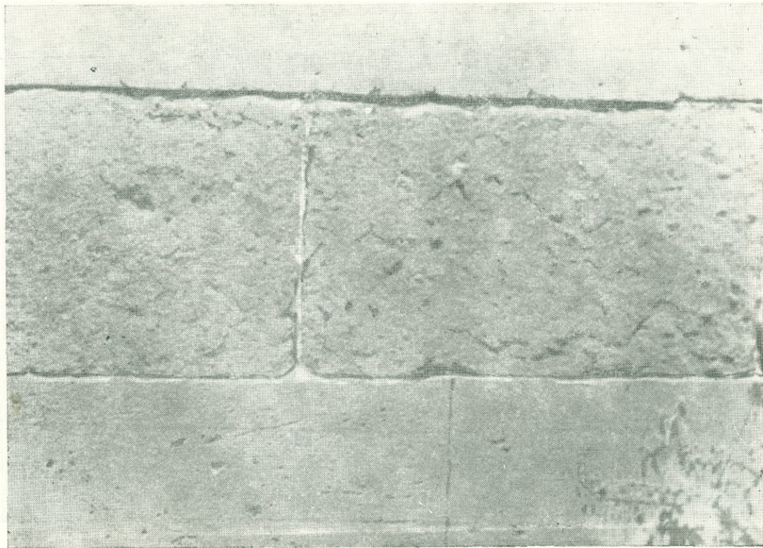
Фиг. 96. Ереванский гос. университет, 1910—13 гг. Фрагмент цоколя южного фасада.
