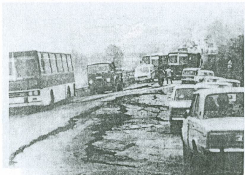
Рис. 3.23. Трещины, образованные в проезжей части дорог [216].
