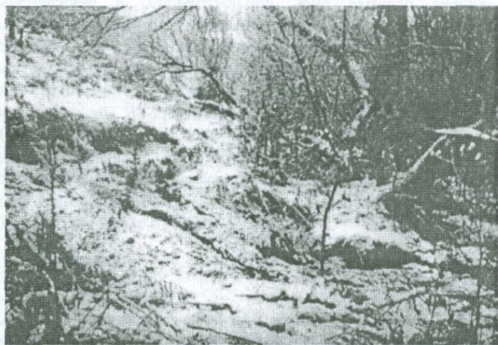
Рис. 3.18. Оползни в западной части города Ленинакана, образованные из-за землетрясения [198].
