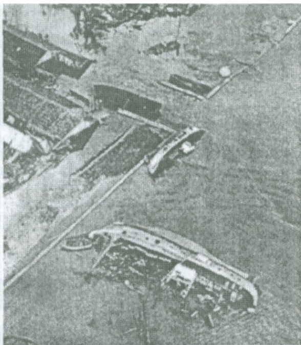
Рис.1.10. Последствия цунами на японских берегах от Чилийского землетрясения 1960 года.
