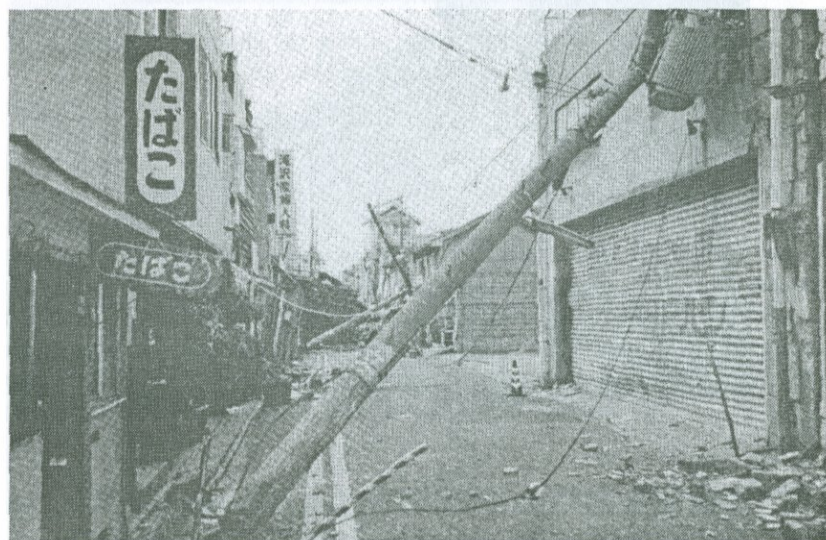
Рис.1.8. Разрушения столбов линии электропередач при землетрясении 17 января 1995 года в Кобе [209].
