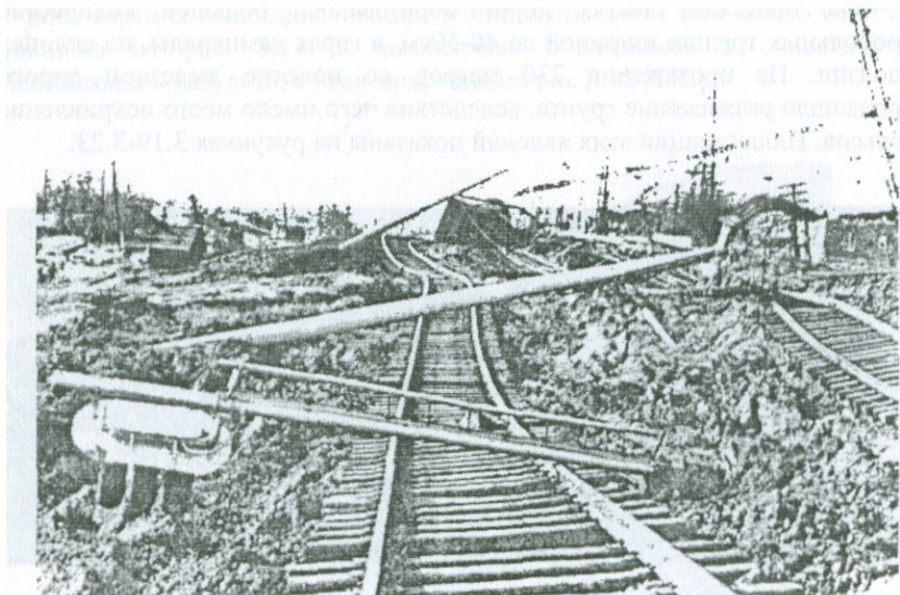
Рис. 3.22. Повреждения железной дороги около станции Налбанд [216].
