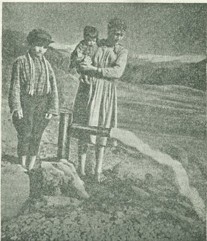
Джермук. Буровая скважина по окончании работ
