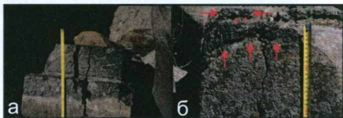
Рис. 5. а) зоны термической закалки на базах колонн; б) пузырение расплавленного туфа.
