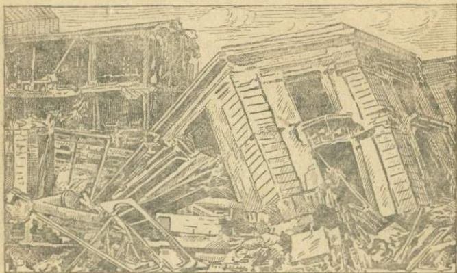
Рис. 3. Разрушения в г. Консепсионе (Чили), вызванные землетрясением в 1939 году.
