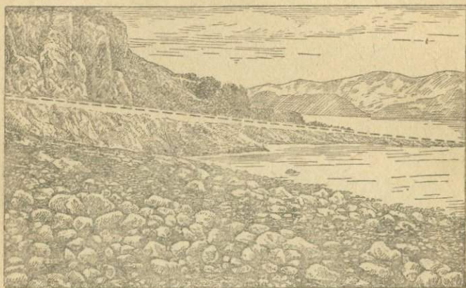
Рис. 10. Дно моря, поднятое на 6,7 метра при землетрясении 1899 года на Аляске в Северной Америке (пунктиром показано положение линии берега до землетрясения).
