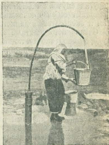
Караганда. Разведка на воду. Сквжина № 16 (артезианский колодец на месте скважины).
