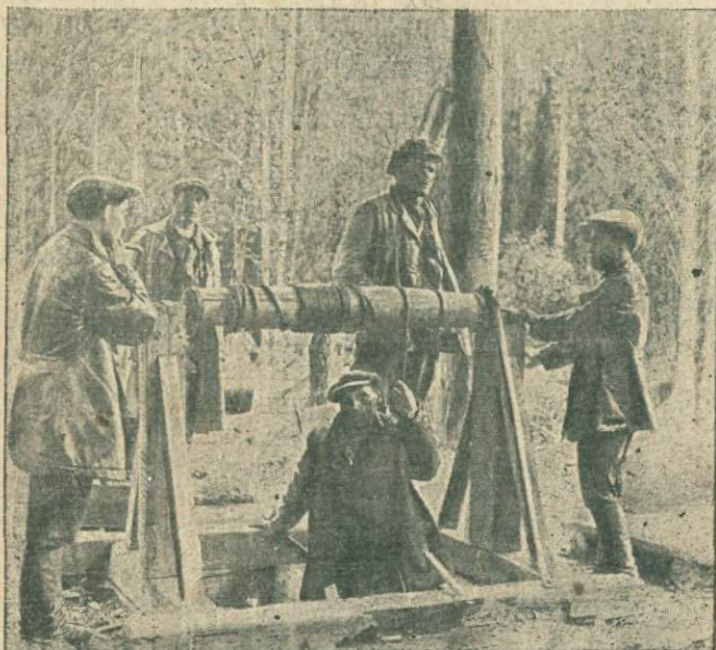
Спуск рабочего в шурф. (Горная Шория, Западная Сибирь).
