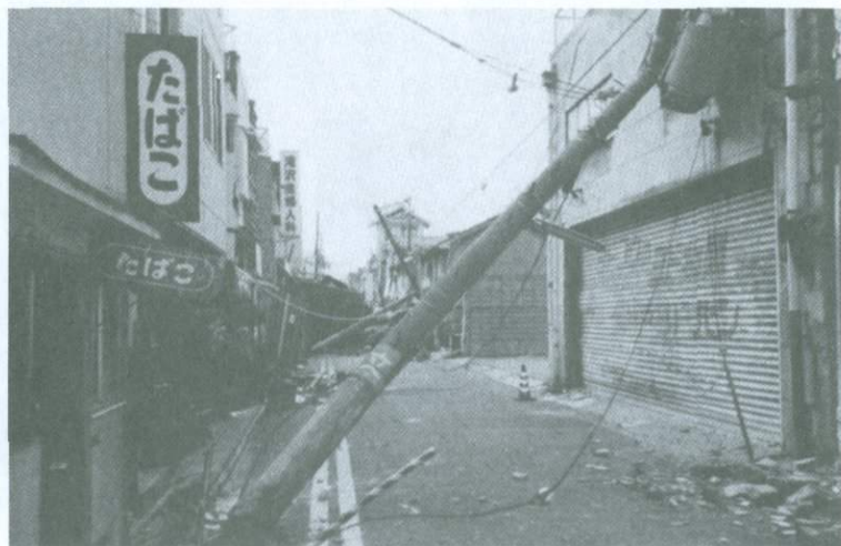
Рис. 42. Разрушения столбов линии электропередач при землетрясении 17 января 1995 года в Кобе [77].
