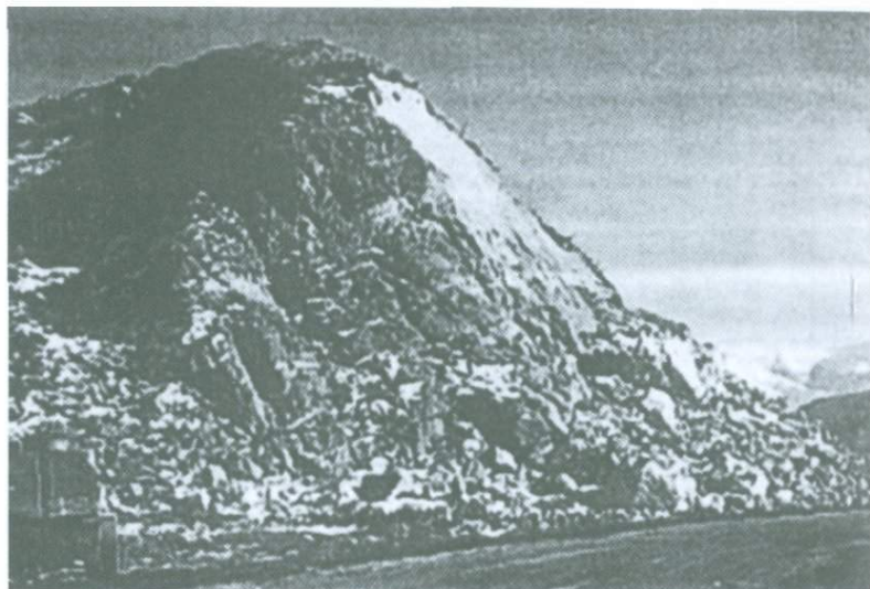
Рис. 16. Оползание-перемещение вулканических туфовых пород в западной части Спитака [1].
