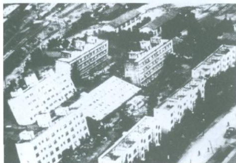
Рис. 40. Последствия землетрясения: а. опрокидывание зданий из-за разжижения грунта (Ниитата, 1964) [39]. б. разрушение газопровода (диаметр 1м) при землетрясении [76].
