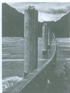
Рис. 40. Последствия землетрясения: а. опрокидывание зданий из-за разжижения грунта (Ниитата, 1964) [39]. б. разрушение газопровода (диаметр 1м) при землетрясении [76].
