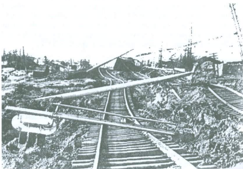
Рис. 17. Повреждения железной дороги около станции Налбанд [4].
